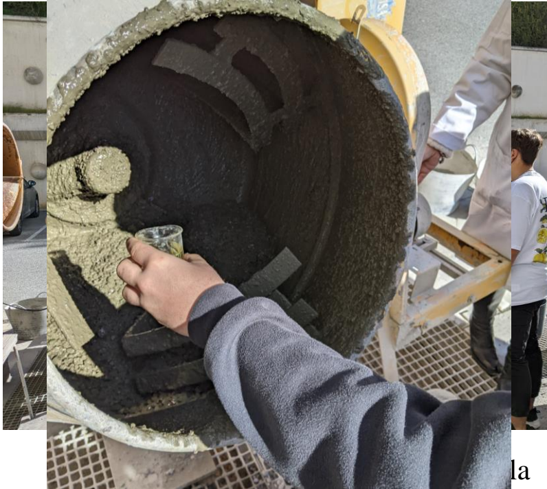
Adición de aditivos aditivos para mejorar la fluidez
